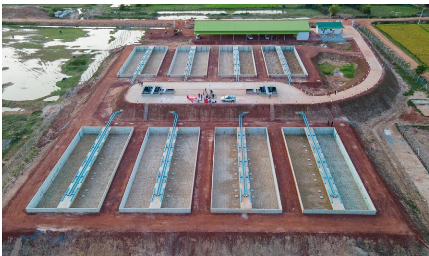
Vue aérienne du projet de Siem Reap (Cambodge) avant mise en eau des filtres
