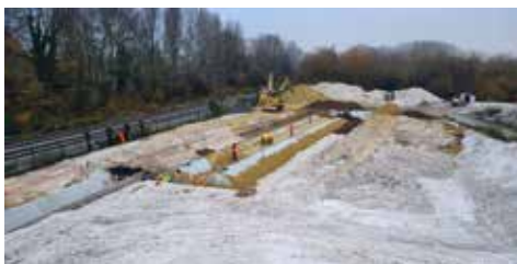
Les travaux engagés par la société IMERYS.
