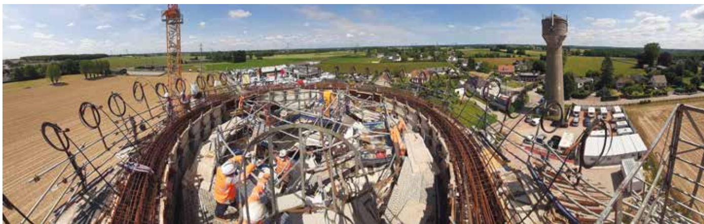
Construction d'un réservoir d'eau de 2 500 m 3 .
