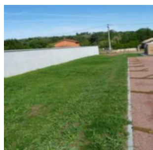
Figure 9 : Noue enherbée à Commelle Vernay (source : Roannaise de l'eau)
