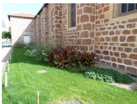
Figure 14 : Massif stockant de la place de l'église à Le Coteau (source : Roannaise de l'eau)
