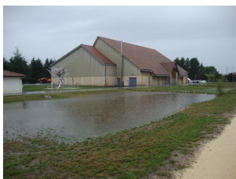
Figure 13 : Bassin d'infiltration de la salle de sports de Commelle Vernay (source : Roannaise de l'eau)
