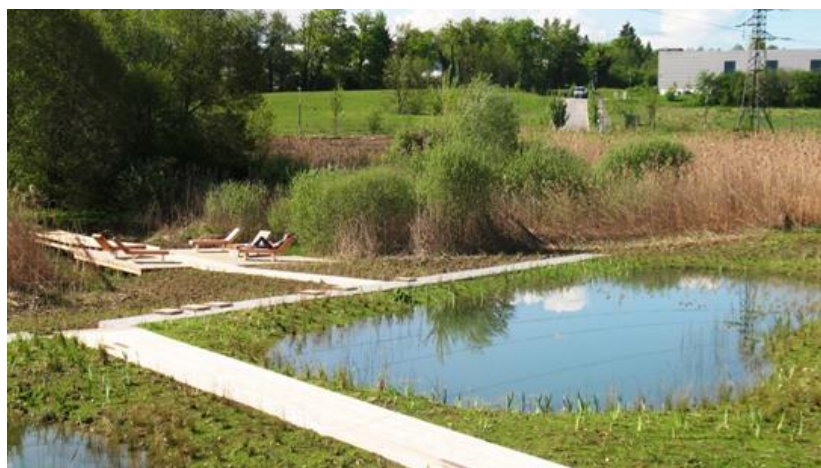
Figure 38 Bassin d'infiltration Source : Montmasson
