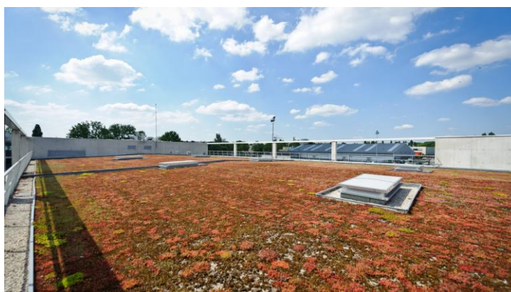
Figure 45 Toiture végétalisée Source : CEREMA 36
