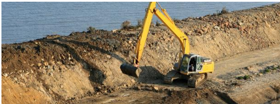
Construction de digue en Vendée après la tempête Xynthia : un exemple de mesure d'adaptation (Source : actu-environnement)
