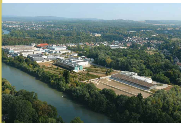
Usine de production d'eau potable de Méry-sur-Oise, propriété du SEDIF
