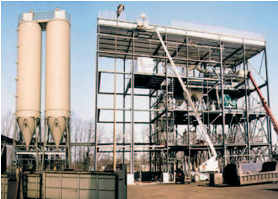
Les silos de sable à traiter et le bâtiment de la régénération des sables avant la pose du bardage
