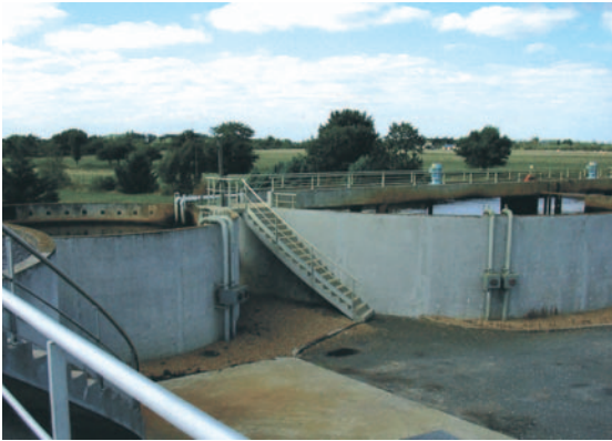
Station d'épuration de Saint-Sylvain-d'Anjou
