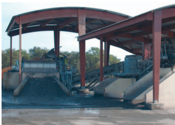
Usine d'incinération de la communauté urbaine
