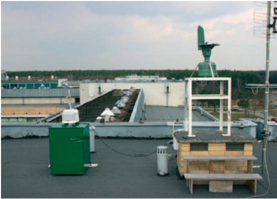
Station de collecte à Poznan en Pologne
