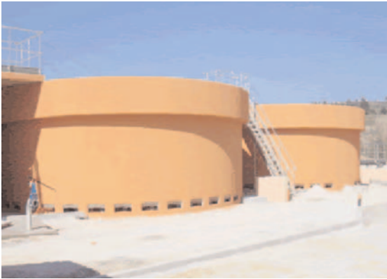
Lombrifiltres-station du Miège-Commune de Combaillaux (34)
