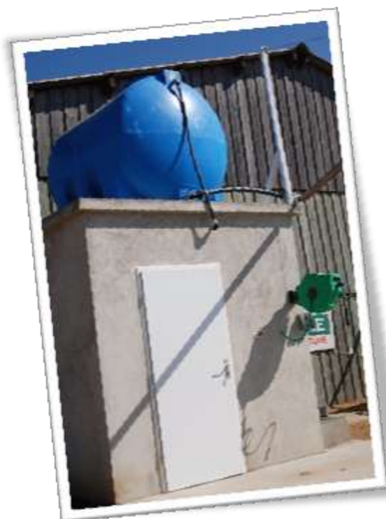
Local technique et cuve d'eau claire en hauteur permettant le remplissage rapide du pulvérisateur par gravité et surtout une impossibilité de retour de produits phytosanitaires dans le réseau d'eau potable. La cuve peut être raccordée aux eaux de toitures pour utiliser l'eau de pluie.
